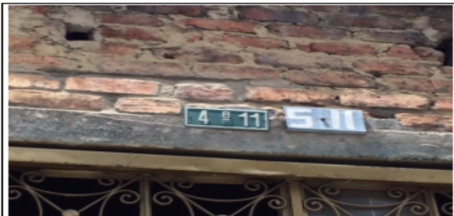
FOTOGRAFÍA 1: NOMENCLATURA DEL PREDIO
